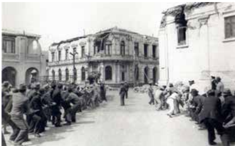
Trabajos de demolición con posterioridad al terremoto, 1939. Fuente: resumen.cl
