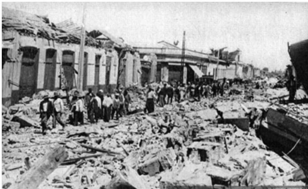
Destrucción dejada por el sismo. 1939. Fuente: Memoria Chilena.
